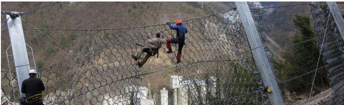
Fase di montaggio di una barriera paramassi.
