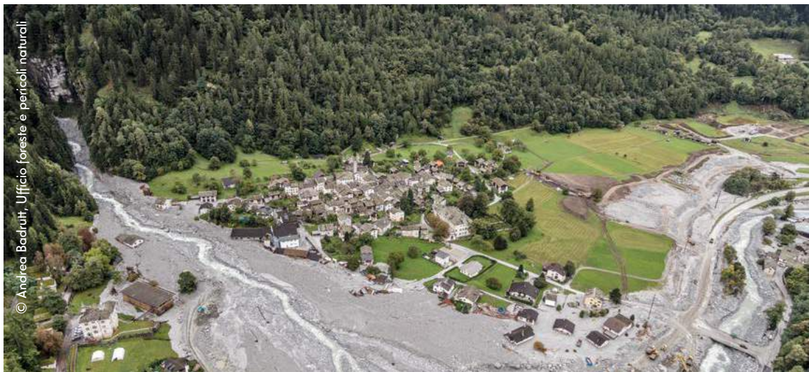
Il materiale ha riempito completamente la vasca di ritenzione. Fortunatamente il vecchio nucleo del paese di Bondo non ha subito danni.
