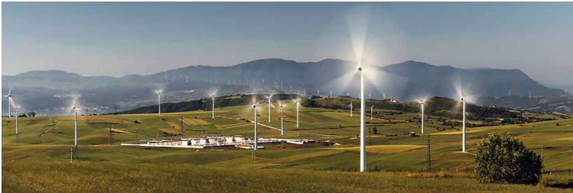
Impianto eolico CER operato dalla società WinBis del Gruppo Axpo. Dell'intero parco eolico operato da WinBis (22 aerogeneratori per complessivi 66 MW di potenza installata) 4 aerogeneratori sono dedicati alla fornitura Unilever.
